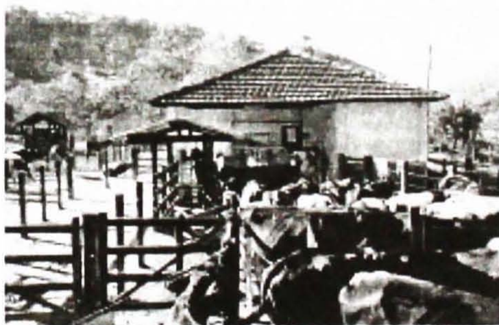
Fig. 6. Instalações para ordenha mecânica e pedilúvio, construídas em 1995.
